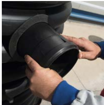
За поврзување на цевката со шахтата се поставува пластичен адаптер.
