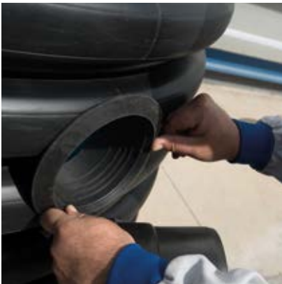
Поставување на страничен приклучок во било која потребна позиција на шахтата. За добра водонепропиуствивост прво се поставува гума-флекс адаптер.
