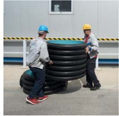
Над дното се поставува телото од ребраста цевка, во соодветно изработен жлеб за добро подесување со дното.
